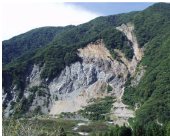
長野県下伊那郡大鹿村 大西山崩壊地 全景
